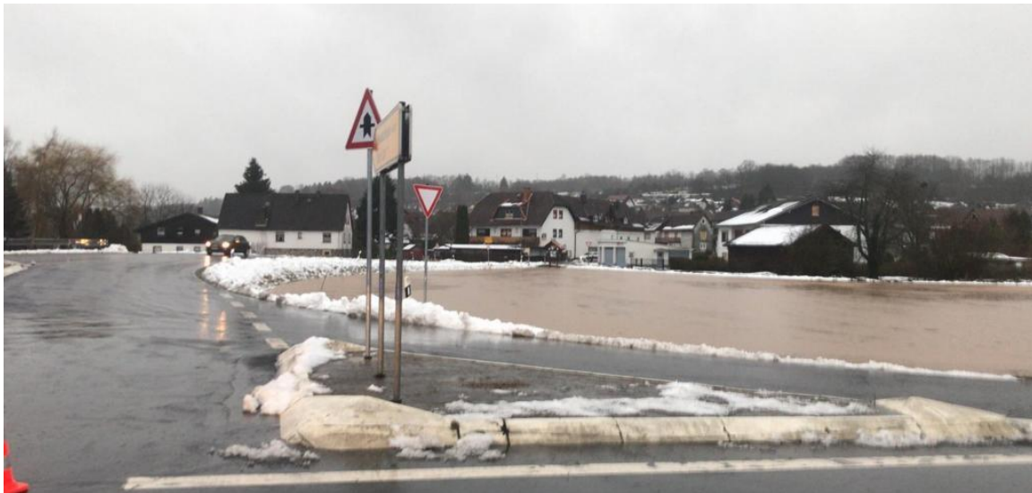
Abbildung 11: Blick von der Kreuzung L3185 Richtung Baufeld mit Wasserstand
