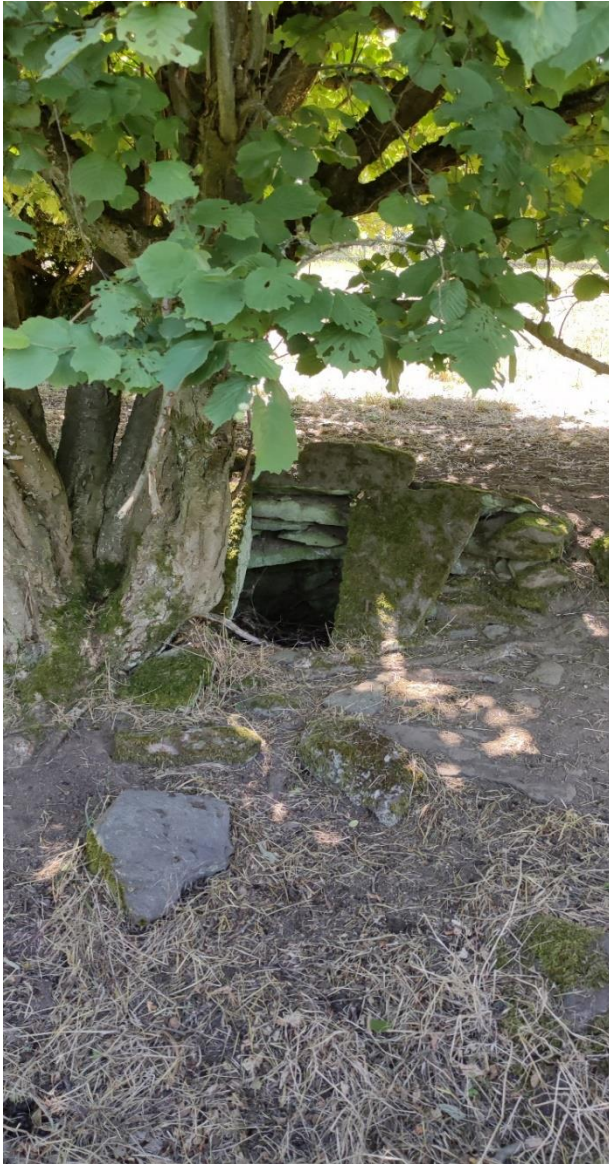
Abbildung 5) Hohlraum im Boden
