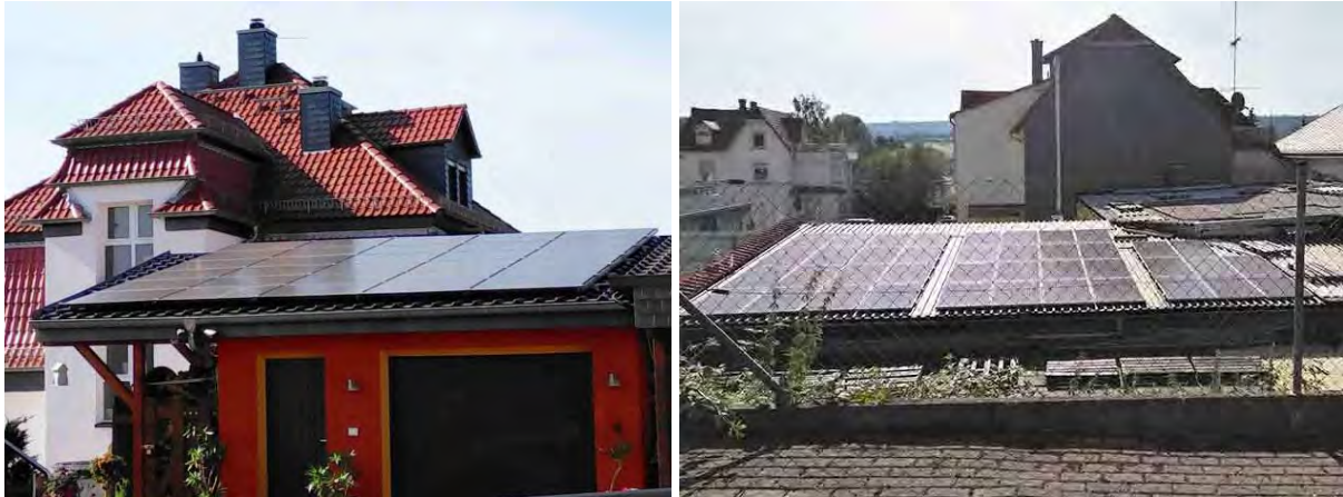
Abbildung 55: Photovoltaikanlagen auf einer privaten Nebenanlage (links) und auf einer Lagerhalle (rechts) in der Hindenburgstraße
