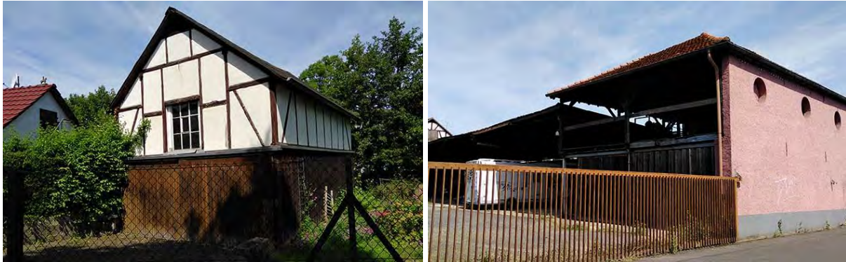
Abbildung 43: Untergenutzte Nebengebäude im Untersuchungsgebiet
