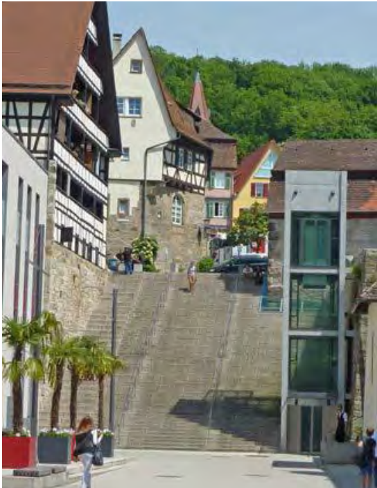
Beispiel für Barrierefreiheit mit Aufzugsanlage (Bsp. Schwäbisch Hall)
