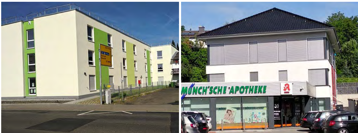
Abbildung 39: Neubau eines Seniorenzentrums und einer Apotheke in der Schillerstraße
