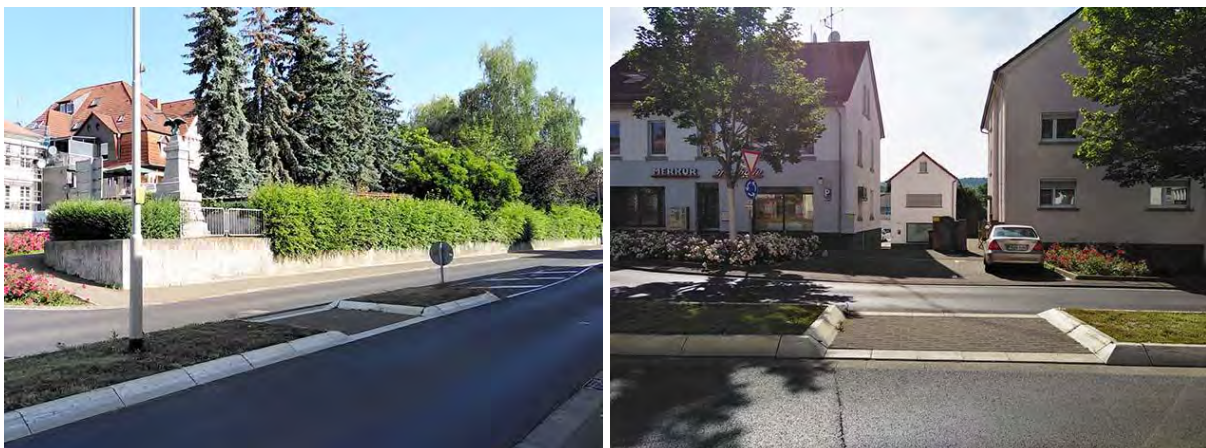
Abbildung 46: Ungesicherte Überwege im Bereich der Kreisverkehrsanlage über die Bismarckstraße (links) und über die Schillerstraße (rechts)
