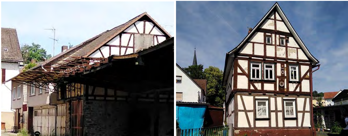
Abbildung 38: Gravierende Baumängel an Gebäuden an der Straße Am Wehr (links) und Gerbergasse (rechts)
