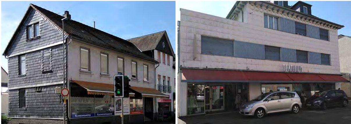
Abbildung 36: Modernisierungsbedarf an Gebäuden in der Schillerstraße
