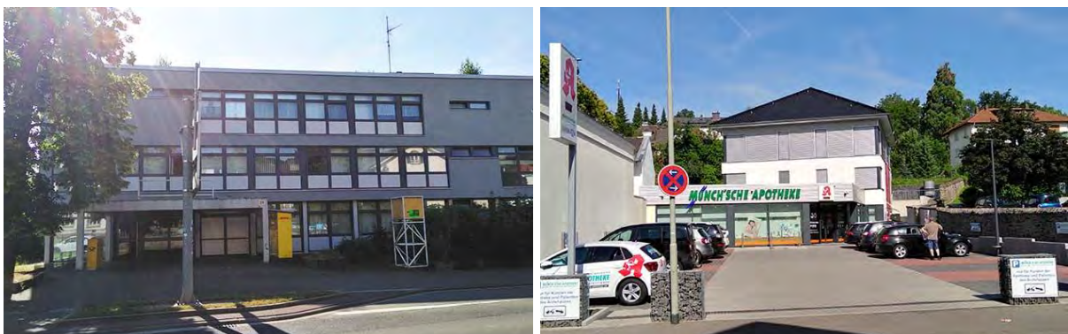
Abbildung 32: Störungen der Raumkante entlang der Schillerstraße
