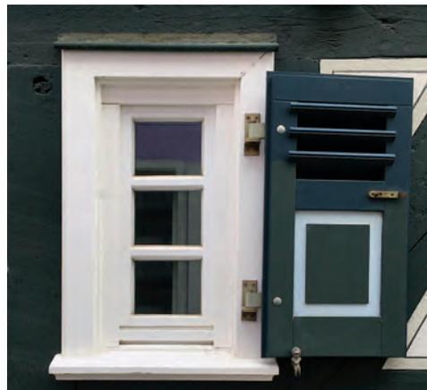
Um ein einheitliches Bild zu schaffen, bietet es sich an, Fenster, Türen und Fensterläden aus Holz, Holz-Aluminium oder in Form einer Stahl-Glas-Konstruktion herzustellen. Eine einheitliche Farbwahl ist ebenfalls von Vorteil.
