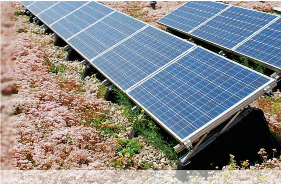
Aufgeständerte Anlagen zur Nutzung solarer Strahlungsenergie sollten so angebracht werden, dass die Anlagen mindestens ihrer jeweiligen Höhe entsprechend von der nächstgelegenen Gebäudeaußenwand abgerückt werden.
