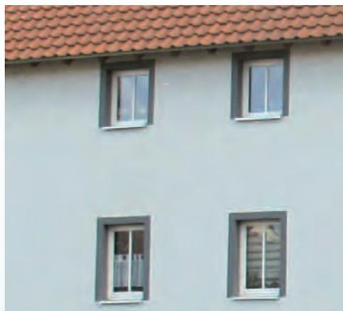
Von den für Nidda typischen Lochfasaden ausgehend, ist der Einbau von großflächigen oder querformatigen (liegenden) Fenstern in Bestandsgebäuden zu vermeiden. Bei Neubauten sind zeitgemäße Fensterkonstruktionen und Fenstereinteilungen zu wählen, stehenden Rechteckformaten ist auch hier der Vorzug gegeben.
