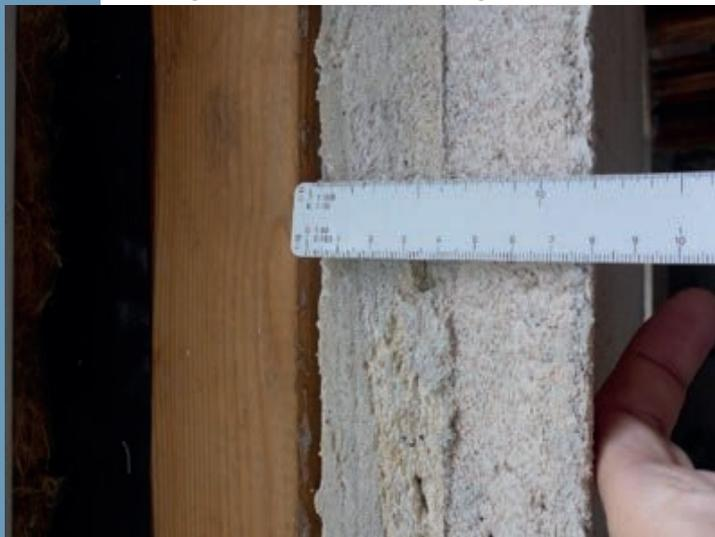
Abb. 28 Innendämmung Wärmedämmputz
