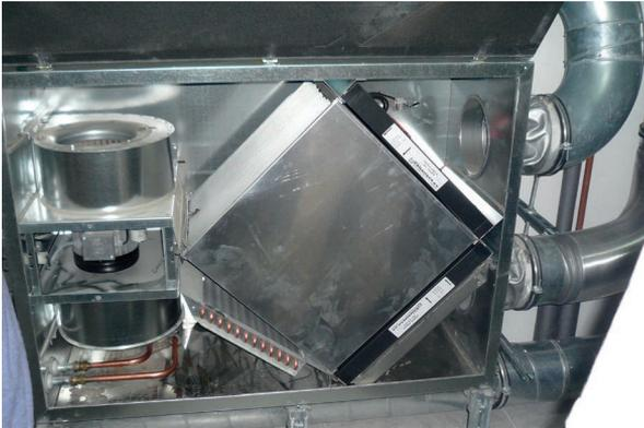
Abb. 37 Lüftungsanlage mit Wärmerückgewinnung und Heizregister
