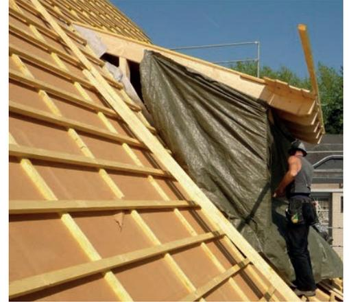
Abb. 20 Holzfaserdämmung als Unterdeckplatte
