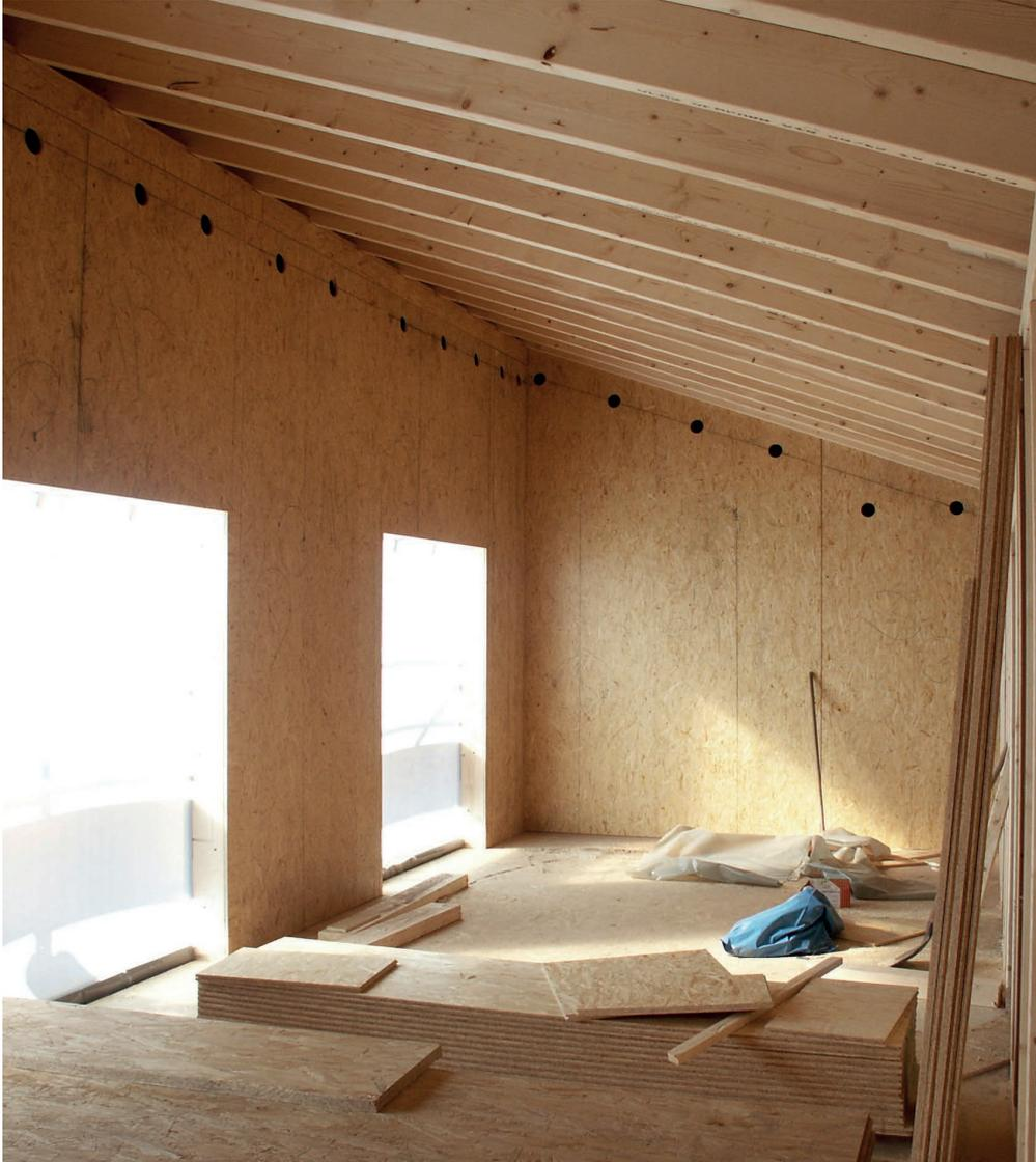
Abb. 19 Holzbauweise mit Zellulose als Einblasdämmung
