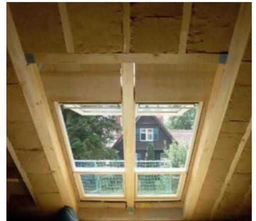
Abb. 21 Holzfaserdämmung als Zwischensparrendämmung
