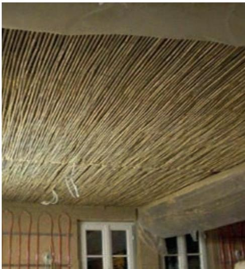
Abb. 26 Schilfrohr als Putzträger
