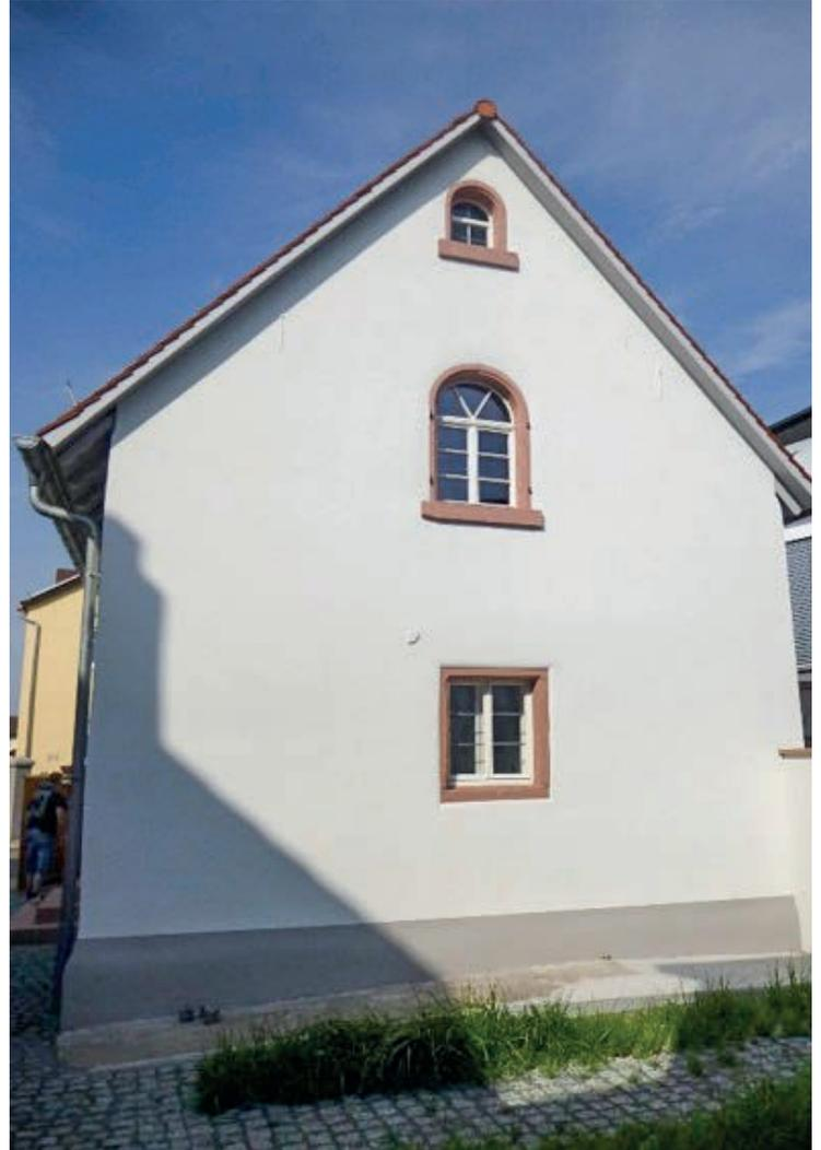
Abb. 36 Sanierung eines historischen Fensters und Modernisierung als Kastenfenster; Die Außenwände wurden mit Wärmedämmputz ertüchtigt
