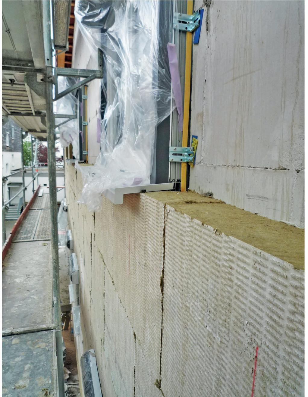
Abb. 17 Wärmedämmung aus Mineralfaser an einem Neubau
