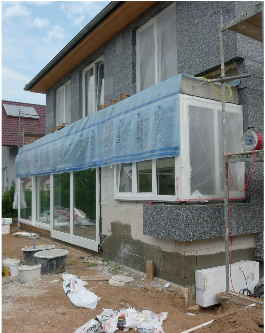
Abb. 15 Wärmedämmung aus Polystyrol an einem Neubau
