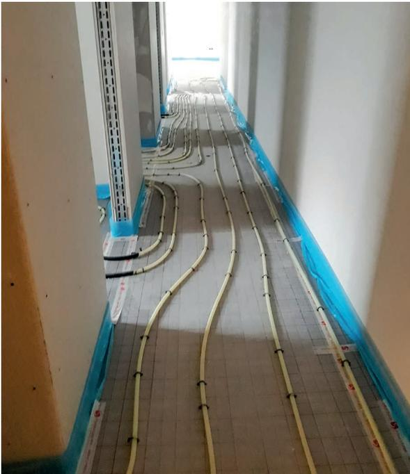
Abb. 38 Fußbodenheizung während Innenausbau
