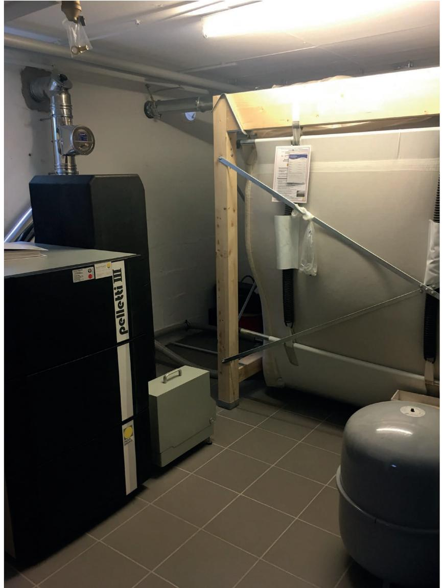
Abb. 39 Pelletkessel (links) mit automatischer Ascheaustragung und Sacksilo (rechts)
