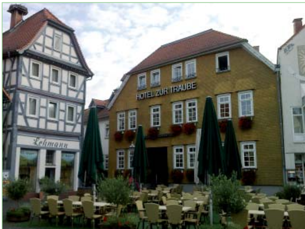
Abb. 11: Die energetische Ertüchtigung von historischem Baubestand stellt auch in Nidda eine große Herausforderung dar.
