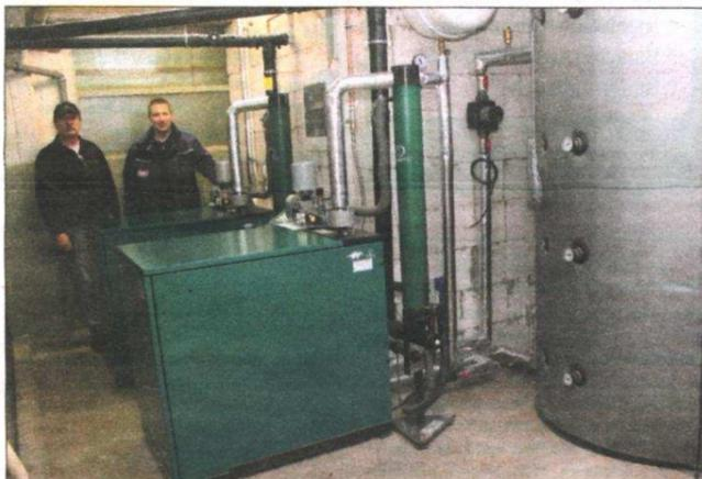
**Die Stötzer GmbH**, rechts Installateur- und Heizungsbaumeister Frank Stötzer, setzte bereits aktiven Klimaschutz mit der Installation von zwei Kraft-Wärme-Kopplungsanlagen von Senertec, Typ »Dachs-Micro KWK« in der M + M Zerspanungstechnik (links Inhaber Norbert Moufang) im Gewerbegebiet Nidda-Harb um.
