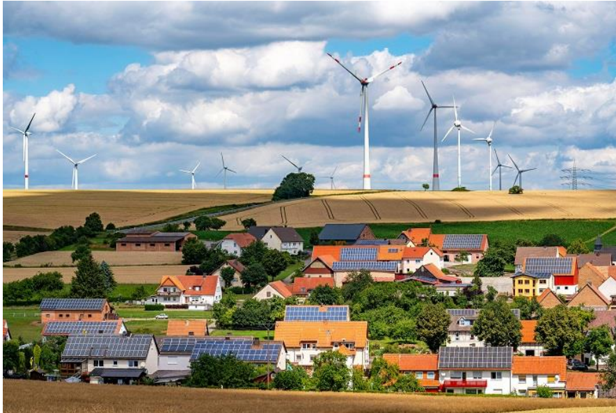
Photovoltaik im privaten Wohnbau
