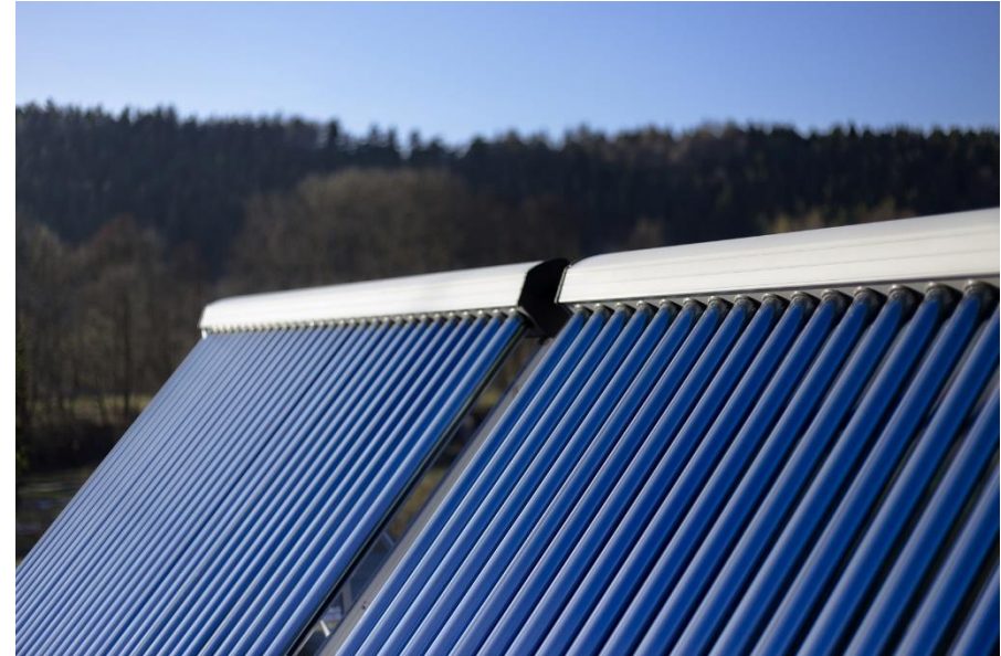
Solarthermie – hier Vakuumröhrenkollektoren
