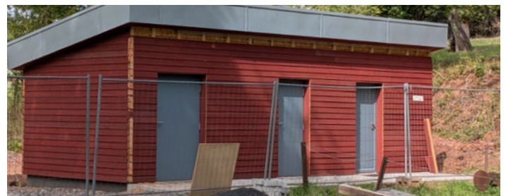
Die fast fertiggestellte Toilettenanlage
