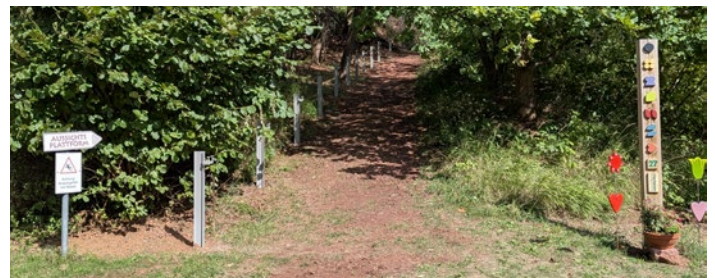
Ein befestigter Fußweg mit Handlauf entsteht
